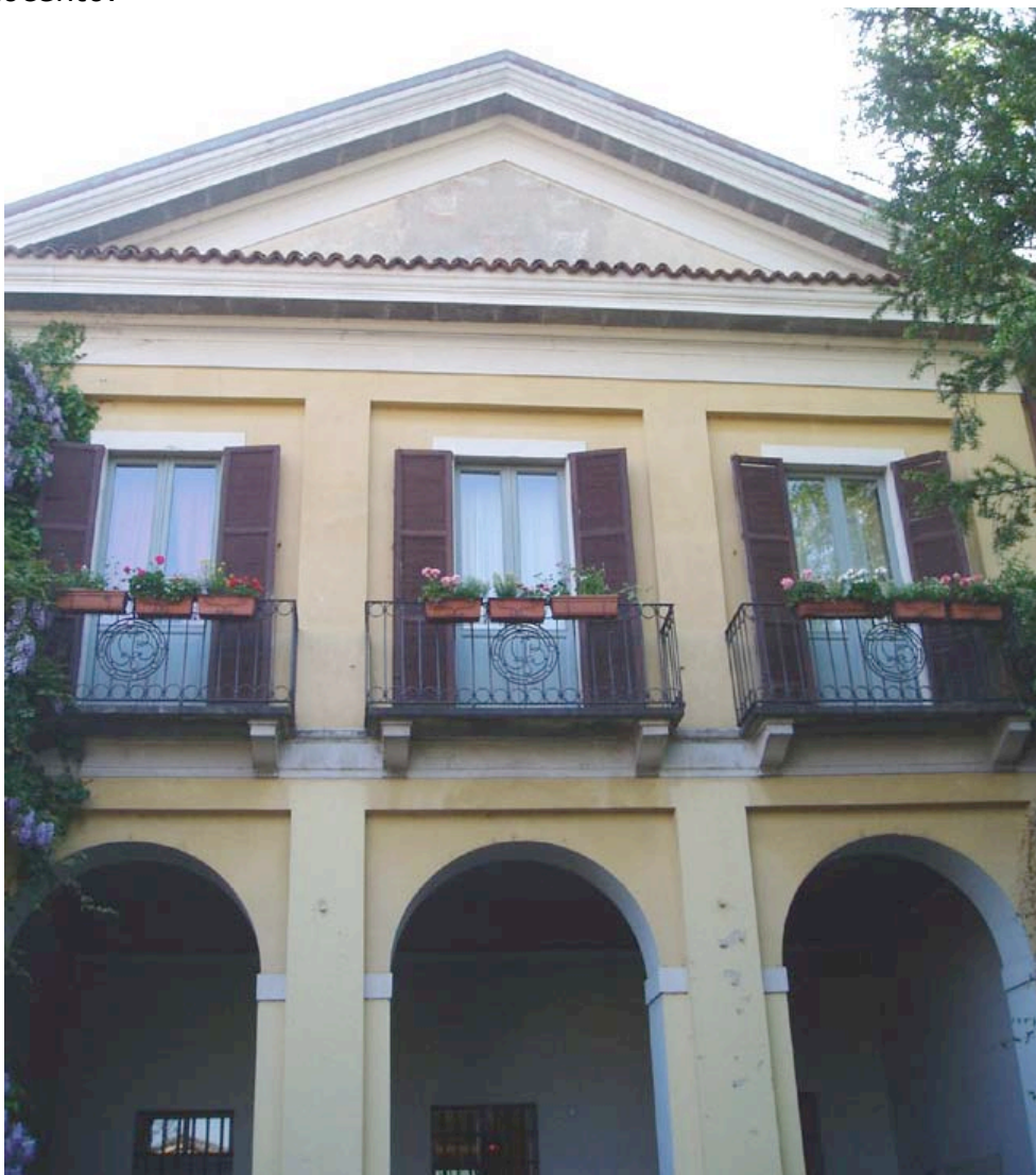
Fig. 55 – Il timpano sulla facciata centrale di villa Birago (foto Cappelli). 338
